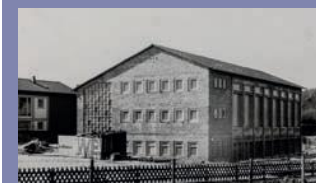
1962 Neubau Turnhalle Holteyer Str.
