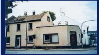
2005 Abriss Vereinsgaststätte Winkelhaus
