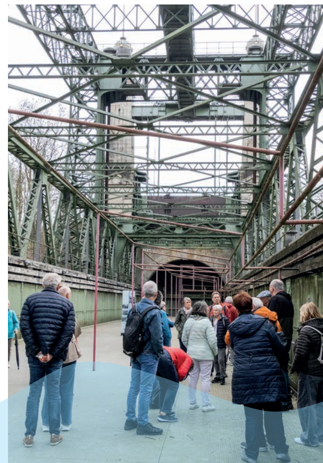
Im Trog des riesigen Stahlkolosses
