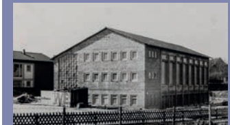
1962 Neubau Turnhalle Hölteyer Str.
